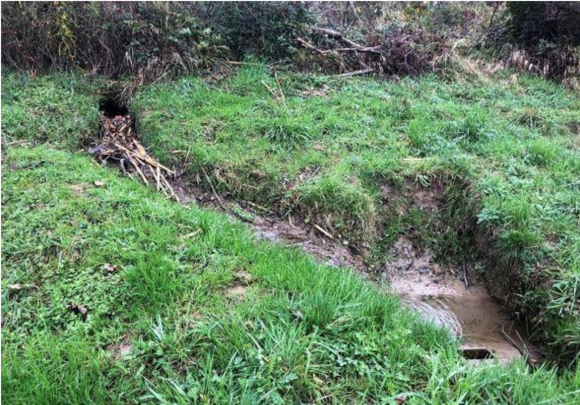
Abbildung 4: Biberdurchstich und Wasserfassung
